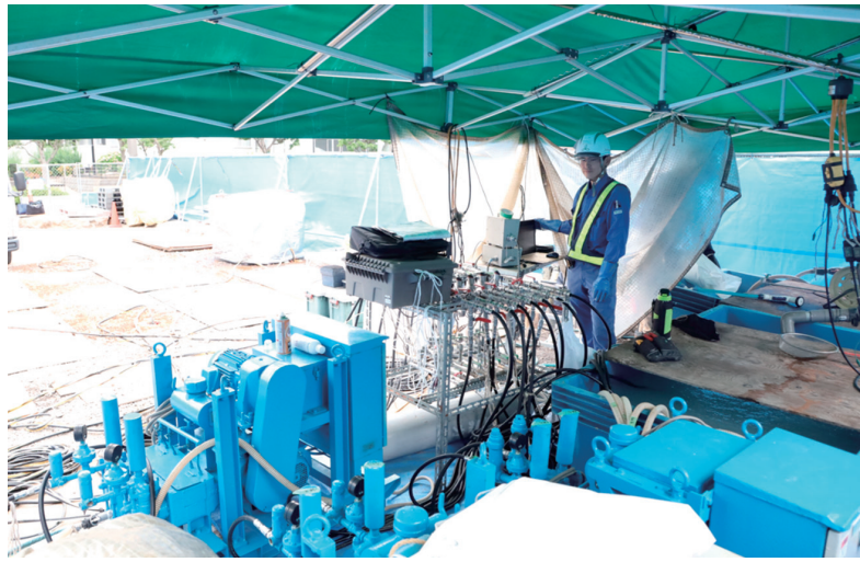
原位置浄化によるクリーニング工場跡地施工の様子(操業しながらの浄化も可能)
