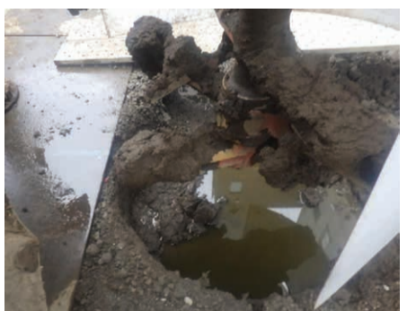
▲サンランドリーの土壌浄化工事
