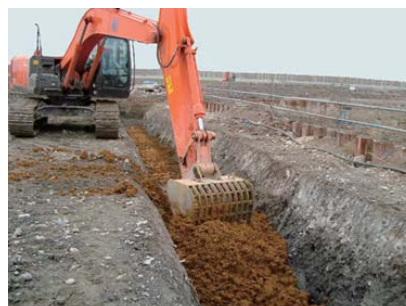
過濾層施工例
