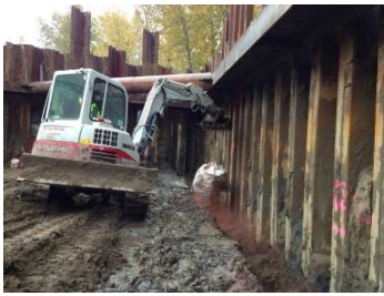
施工方（例）：机械混合
