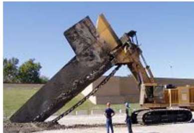
施工方（例）：吸附阻隔墙
